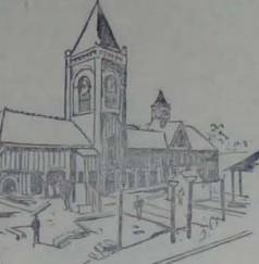
ESTACION DE MOTT HAVEN
