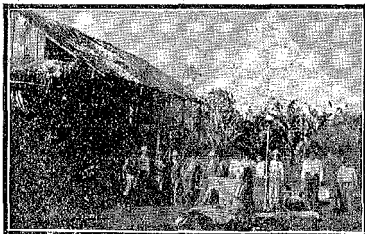
CAMPAMENTO DE "LA UMBRIA". HACIENDA QUE QUEDA MUY CERCA DE LA LINEA EN PROYECTO.
